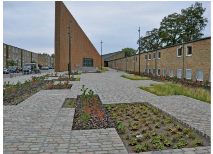
Engelsk brolægning i Tingbjerg
