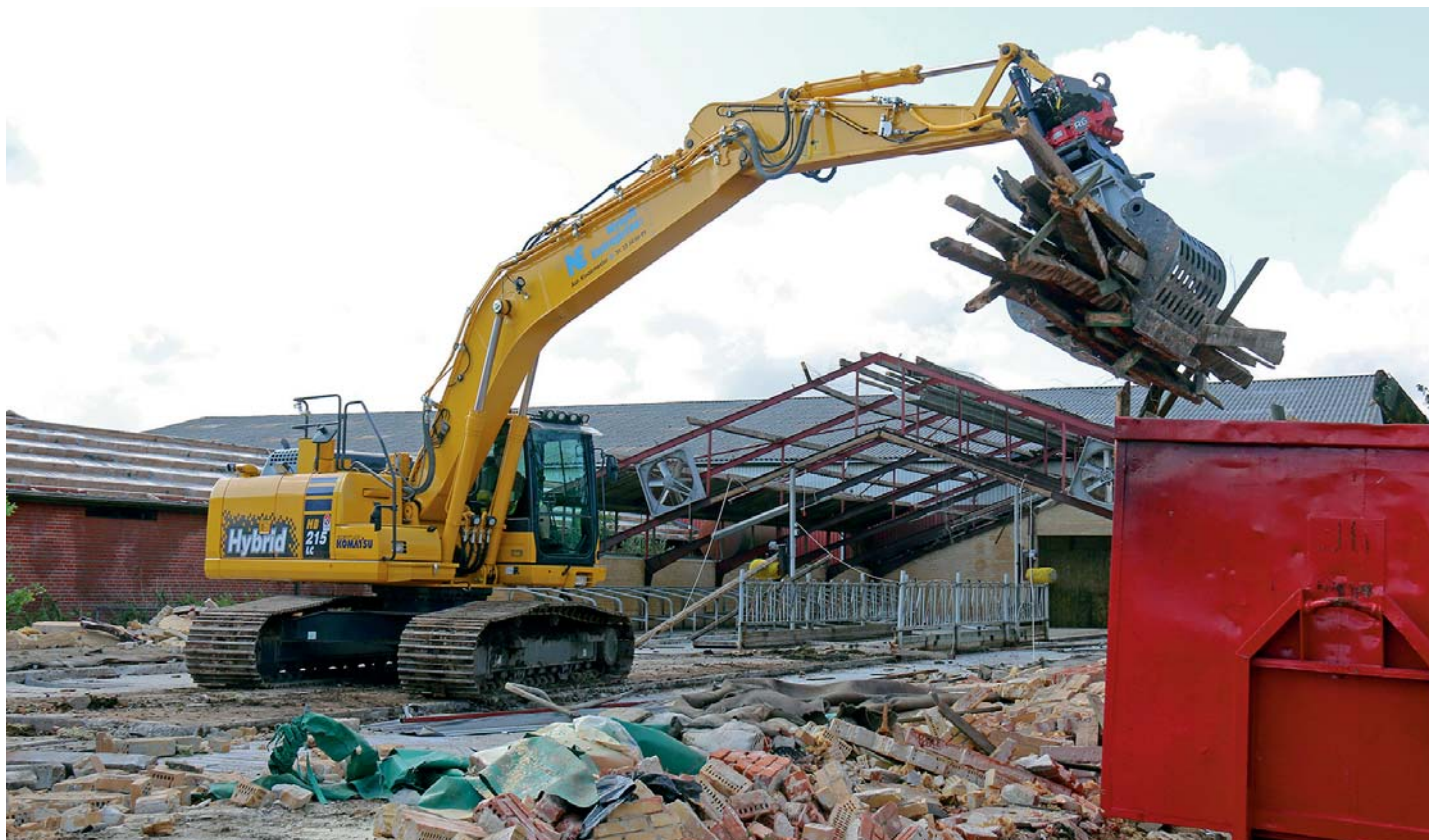
Der krøjes på livet løs under nedbrydningen af de gamle landbrugsbygninger uden for Herning. Jo mere krøjning, jo bedre. Hybridteknikken indfanger og regenererer energi netop, når maskinen svinger rundt.
