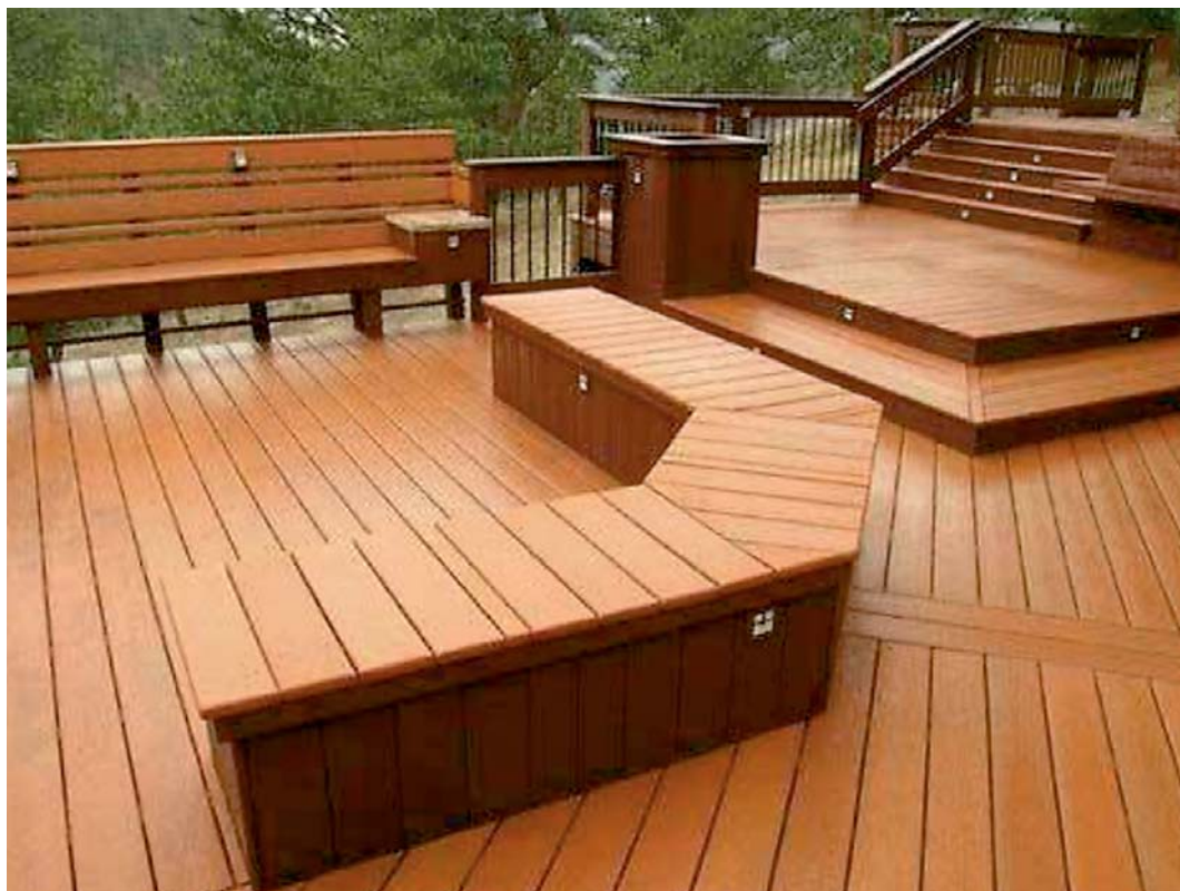
Eksempel på wood polymer composit material, altså et materiale lavet af træaffald og polymerer. I praksis ligner det træ.
