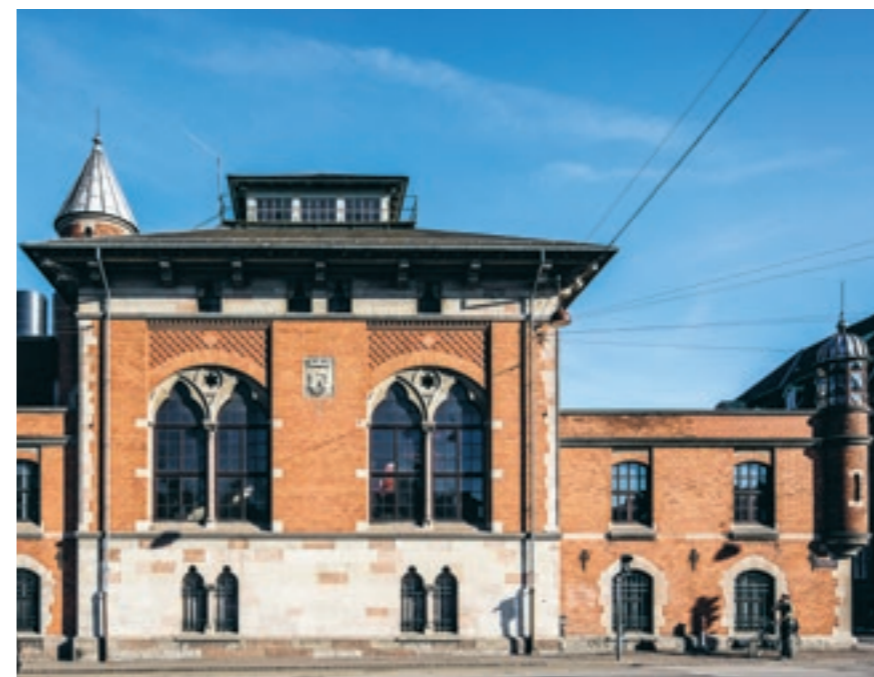
Vestre Elektricitetsværk, opført 1896-98 i København i en pompos og monumental udformning.
