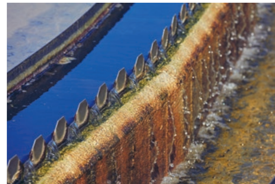
Efter grovsorteringen tager bakterierne over og starter den biologiske proces, der sørger for, at de organiske stoffer samt fosfor og kvælstoffer reduceres betydeligt, inden vandet sendes ud i Lillebælt.
