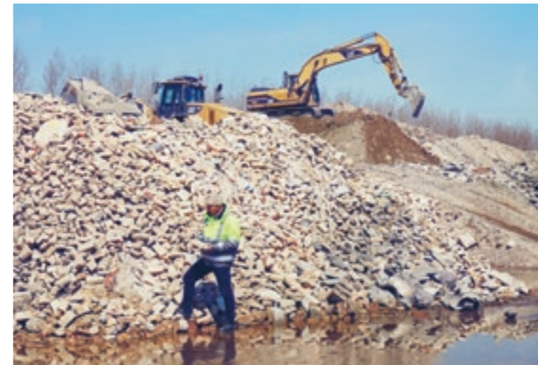
Byggeaffaldet, som RGS 90 får ind, bliver sorteret, knust eller granuleret for derefter at blive genbrugt som f.eks. vejunderlag eller isoleringsmateriale.
